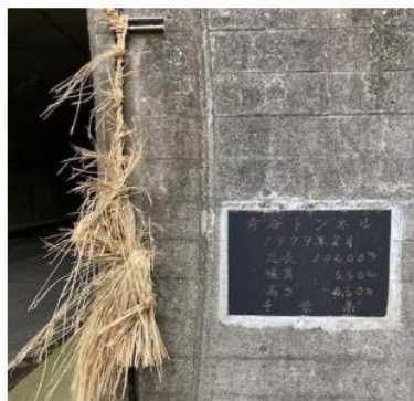
中三原区 寺谷トンネル
