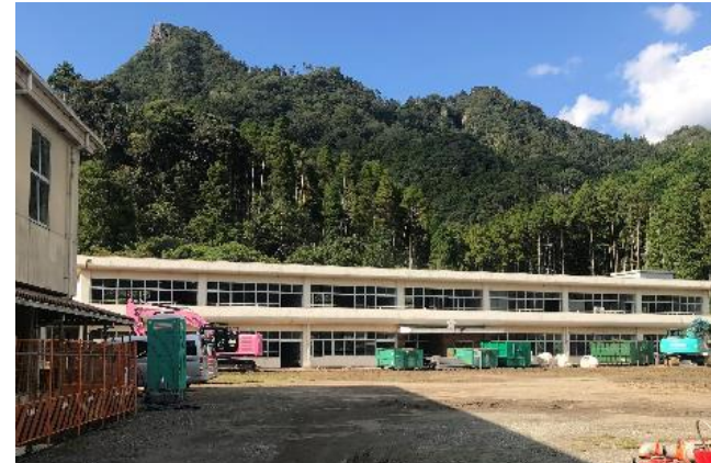
解体工事は、9月の下旬から開始された。来年2月末までに工事は完了の見込み。
