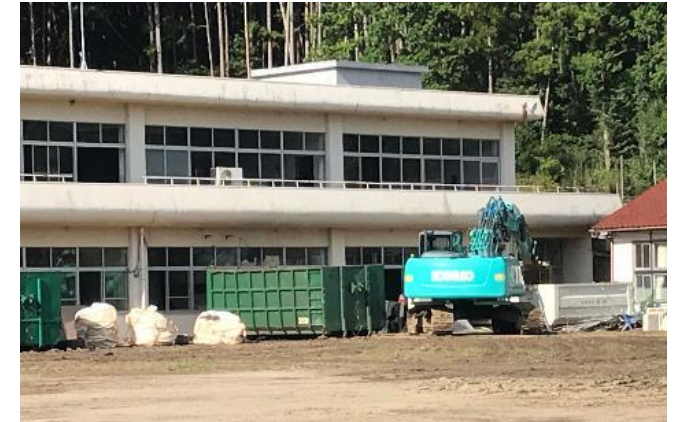
校舎と共に、幼稚園園舎宿直室、給食室なども解体される。解体自体は12月中旬終了予定。
