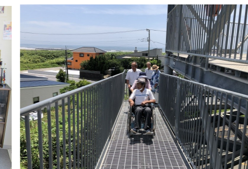
車いすでの避難が可能な津波避難タワー
