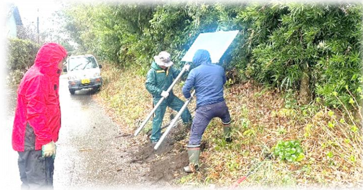
雨が降る中での作業でしたが段取りよく設置ができました
