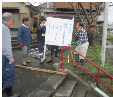
稲荷神社の作業風景
