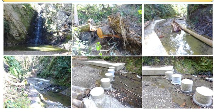
一昨年の台風による暴風雨で大きな被害を受けた花嫁街道で、倒木や、壊れたままになっていた沢を渡る飛び橋が、和田浦歩こう会を中心としたボランティアの皆さんによって補修され、春のハイキングシーズンを前に整備されました。行く手をふさいでいた巨大な倒木はチェーンソーで切断されて撤去され、濁流に流された飛び橋のベースは新たにコンクリートで固められ、安全に通行できるようになりました。
