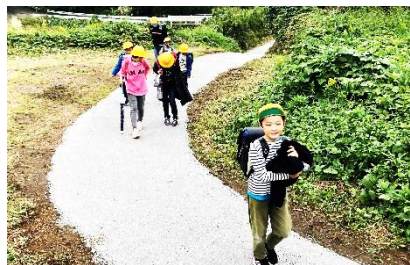
整備後。きれいに土砂も敷かれて安全な通学路に修復された。
