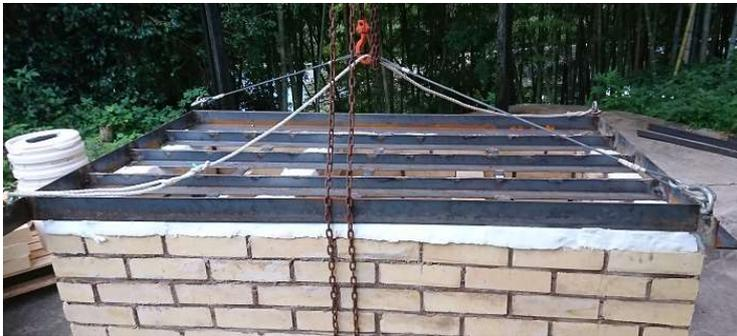
吊りボルト4本にワヤとロープで吊り上げます。この段階では自体の荷重でやや変形しますが、セラミックファイバで吸収できる程度です。
