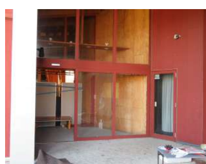
ホール側入口（外側から）
