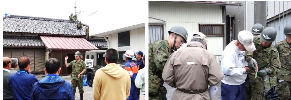
市部公会堂の屋根に隊員が登って、実際ブルーシートを張りながら説明された。
