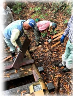
上から順に施工
