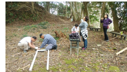
倒れた看板を補修しました
