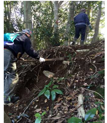
滑りやすい場所に階段設置
