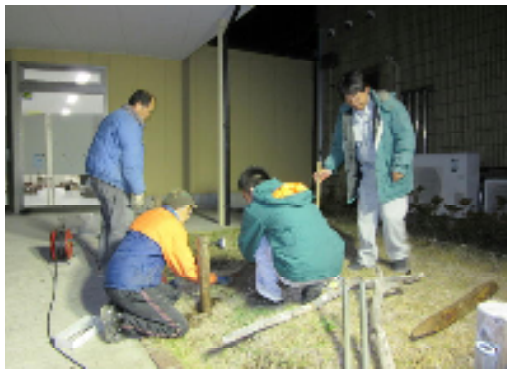
慎重に縦杭を打つ
