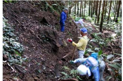
当日未明にも激しい雨が降って、山道には枯れ枝や土砂が堆積して、非常に滑りやすい状態でした。10月6日に一度整備作業を行ったルートですが、再度斜面の土を削ったり倒木を細かく切って階段を作ったりと、9時から二時間半の作業を行いました。
