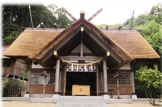
屋根の葺き替えられた拝殿
