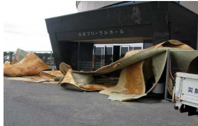
ホール入り口を塞ぐ断熱材
