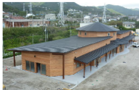
斜め上空からの様子
