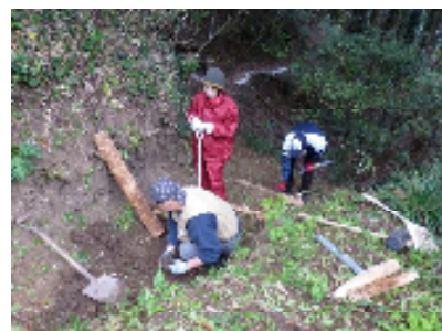
仁我浦地区の避難路の整備
