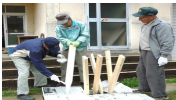
小雨が降る寒い中、腐りにくいように防腐剤を塗ります
