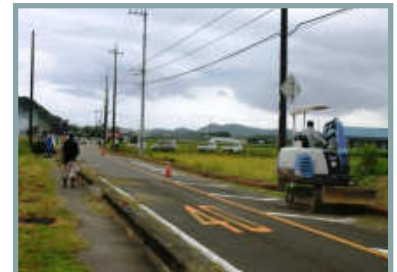
撤去作業無事終了
